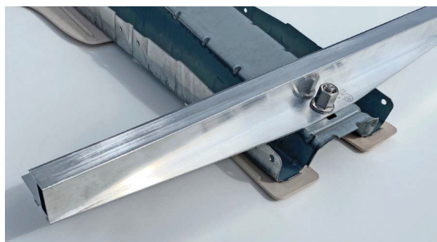
Posizionamento del SSM2 previo SR Pad lungo le linee tracciate col "battifilo"
