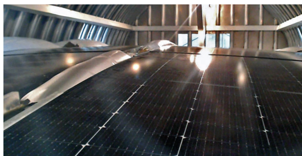
Prova di carico del vento su SSM2 con orientamento est-ovest.
