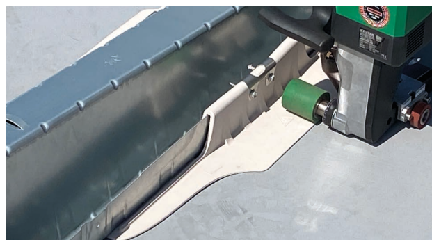
Saldatura ad aria calda di una flangia SikaRoof® Click con una saldatrice semi-automatica.
