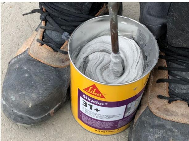
Miscelare la confezione da 1kg di **Sikadur-31** o in alternativa eseguire le fasi di preparazione della cartuccia dell'ancorante chimico a base epossiacrilata **Sika Anchorfix-2+**. Sika Anchorfix-2+ ha un tempo di indurimento inferiore; di conseguenza permette di ridurre i tempi di attesa tra la posa degli iniettori e l'inizio dell'iniezione. In condizioni climatiche standard, con Sikadur-31 si raccomanda di attendere almeno il giorno successivo per l'esecuzione dell'iniezione.
