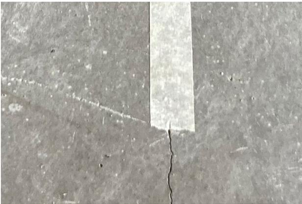
Prima di stuccare il resto della fessura è possibile applicare del nastro adesivo fine lungo la fessura stessa. Questo metodo permette di agevolare il collegamento tra due iniettori consecutivi, specialmente in caso di fessure di basso spessore e di ridotta o ignota profondità.
