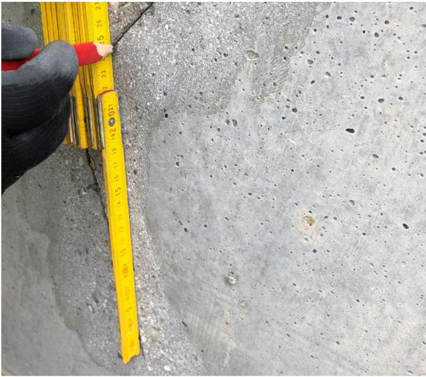
Tracciare il posizionamento dei punti di iniezione. Il passo dei packer dovrà essere circa pari alla profondità della fessura.
