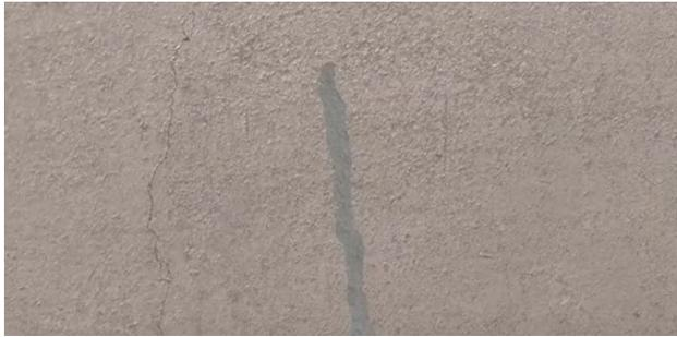
Una volta indurita la resina di iniezione rimuovere lo stucco epossidico e i packer di iniezione tramite abrasione con flessibile a tazza diamantata, ripristinando così la planarità della superficie.
