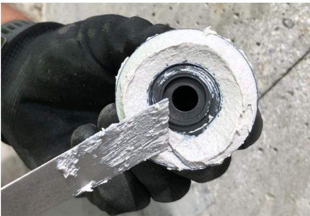
Applicare lo stucco epossidico sul retro dell'iniettore facendo attenzione a non intasare il foro di iniezione.
