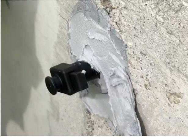
Stuccare il contorno dell'iniettore per evitare fuoriuscite di resina durante l'iniezione. L'iniettore dovrà avere la saracinesca aperta nel momento dell'installazione.
