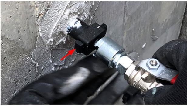
Interrompenre la fase di pompaggio (pompa manuale) o chiudere valvola alla testa del tubo di iniezione (serbatoio o pompa elettrica). Chiudere quindi la saracinesca del packer da cui si stava iniettando. Tale saracinesca dovrà rimanere chiusa fino all'indurimento della resina. Rimuovere la pompa e collegarla al packer superiore (successivo) da cui fuoriusciva la resina per procedere con nuova iniezione di resina.
