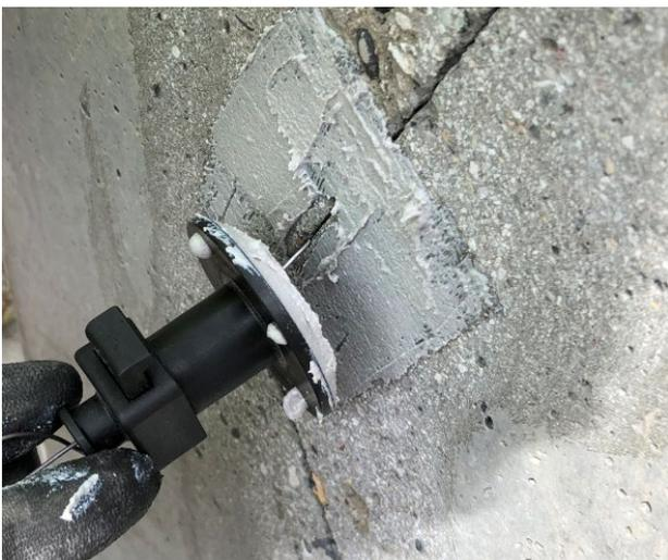
Applicare il packer sulla superficie precedentemente trattata, con l'ausilio di un chiodo o fil di ferro per il centraggio.
