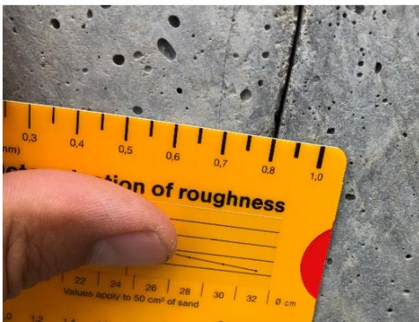
Per un'iniezione agevole con **Sikadur-52 Injection Normal** le fessure dovranno presentare un'apertura di almeno 0,8 mm circa. Possono essere eseguite anche iniezioni su fessure di apertura inferiore ma in questi casi si raccomanda di rivolgersi a un applicatore esperto di iniezioni o di eseguire una prova di iniezione localizzata prima di applicare tutti i punti di iniezione.
