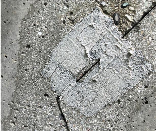
Prima di installare l'iniettore eseguire una rasatura a zero con spatola nella zona di applicazione del packer stesso.
