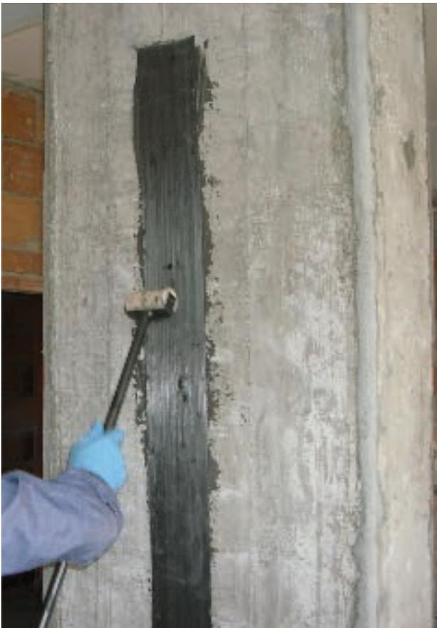
FIG. 2.3 - Esempio applicativo di Sika® CarboDur® LAM
