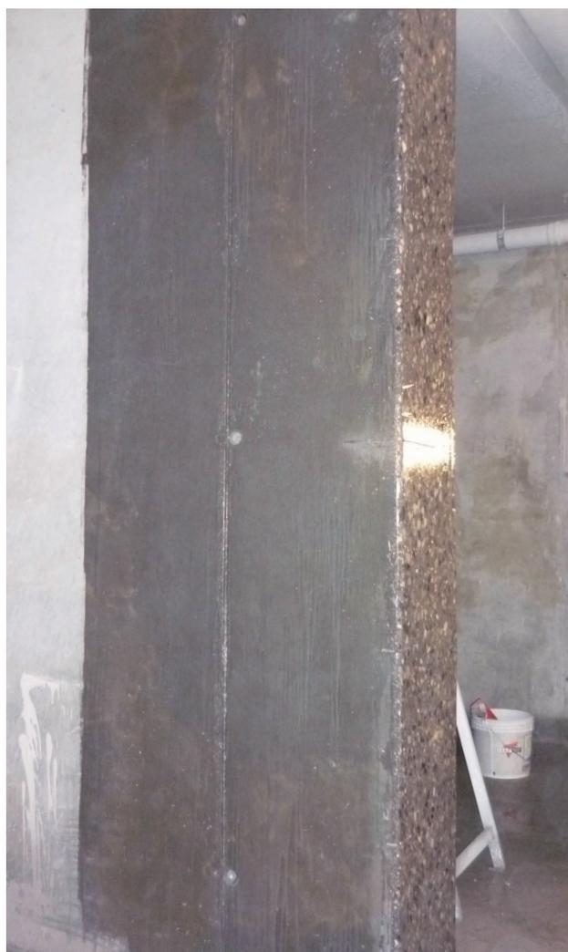
FIG. 6.4.1 - Preparazione del substrato mediante idrosabbatura
