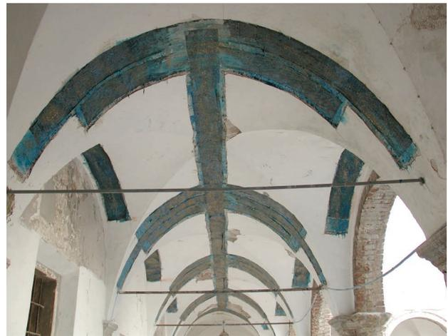
FIG. 7.73 - Intervento su volta all'intradosso con SikaWrap® FIB
