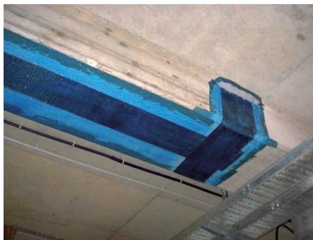
FIG. 6.2 - Intervento di rinforzo eseguito a regola d'arte mediante l'impiego di fasce ad U
