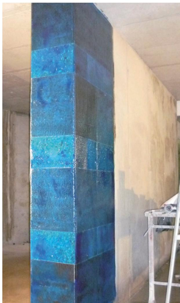
FIG. 6.4.2 - Esempio di intervento di confinamento di pilastro
