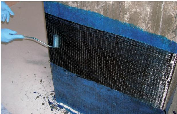
FIG. 5.3.6 - Esempio di applicazione di SikaWrap® FIB per confinamento
