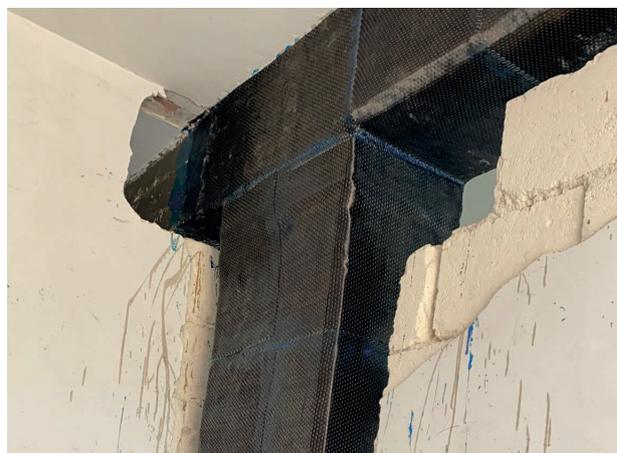
FIG. 7.2.2 - Intervento con materiale composito su nodo trave-pilastro
