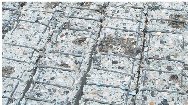
FIG. 5.16 - Negli interventi di ripristino dei copriferro l'idroscarifica ad alta pressione consente una adeguata adesione di interfaccia
