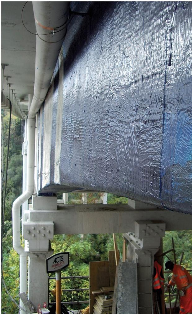
FIG. 5.2.1 - Fasciature SikaWrap® FIB ad U per il rinforzo al taglio
