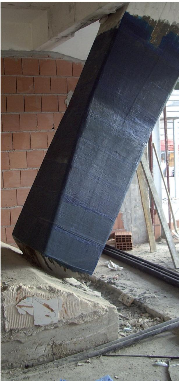
FIG. 7.5.1 - Esempio di intervento mediante fasciatura con SikaWrap® FIB
