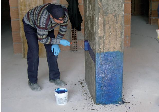
FIG. 5.3.5 - Esempio di applicazione di SikaWrap® FIB per confinamento
