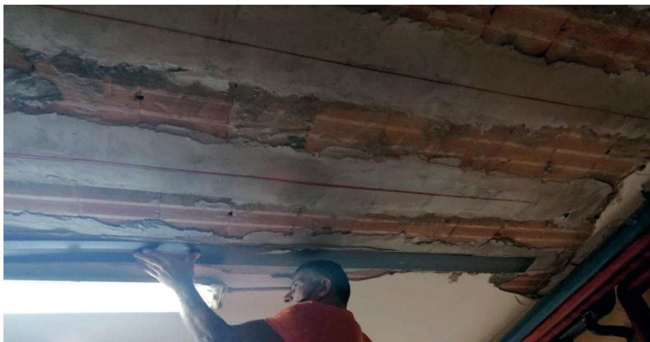
FIG. 4.1 - Esempio di rinforzo di solaio con Sika® CarboDur® LAM
