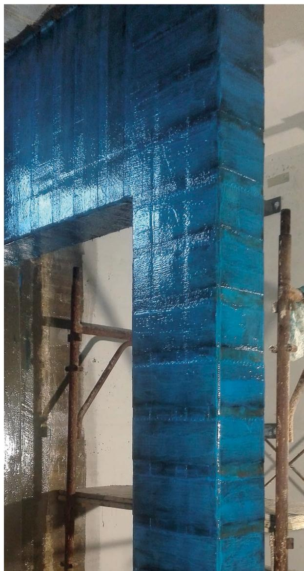
FIG. 2.9 - Esempio applicativo di SikaWrap® FIB
