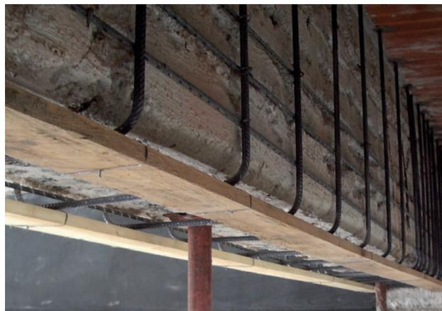
FIG. 7.4.1 - Esempio di rinforzo mediante ringrosso effettuato con Sika® CarboDur® BAR
