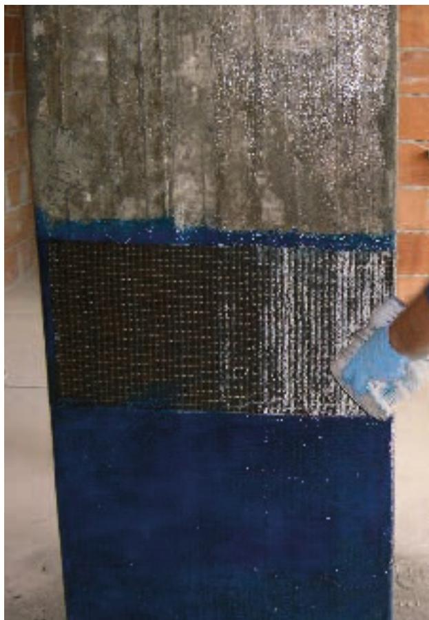
FIG. 2.2 - Esempio applicativo di SikaWrap® FIB
