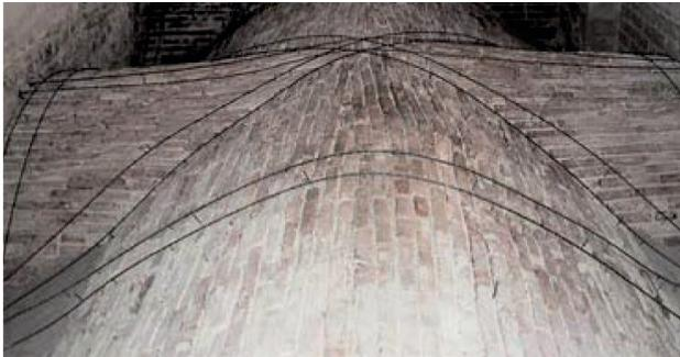
FIG. 7.72 - Intervento su volta all'estradosso con Sika® CarboDur® BAR
