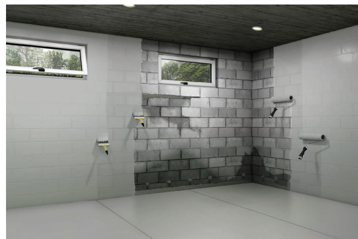
Impermeabilizzazione interna di acqua in contropinta, su muri e pavimentazioni di scantinati
