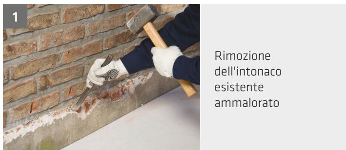
Rimozione dell'intonaco esistente ammalorato
