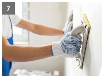
Applicazione della rasatura mediante **Sikamur® Finish**
