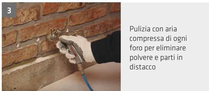
Pulizia con aria compressa di ogni foro per eliminare polvere e parti in distacco
