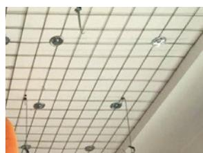
Rete in acciaio con trattamento di zincatura a caldo per adeguamenti sismici, applicazioni in galleria e interventi antisfondellamento
