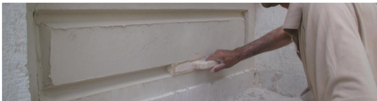
**Intonaci deumidificanti:** la tecnica della deumidificazione con l'utilizzo di intonaci Sika macroroprosi consiste nel sostituire il vecchio intonaco ammalorato con malte traspiranti che consentono di avere un eccellente scambio igrometrico con l'ambiente e, ai sali migranti per risalita capillare dal terreno, di essere accolti nei microvuoti dell'intonaco stesso contrastando la formazione di efflorescenze saline e il conseguente distacco dell'intonaco.
