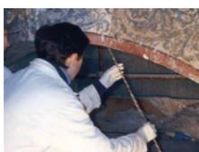
Barre pultruse in fibra di carbonio e di vetro, alta temperatura di transizione vetrosa e aderenza migliorata per il rinforzo strutturale di elementi in c.a. e muratura
