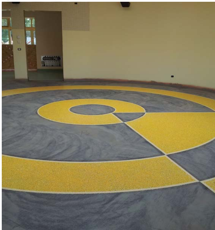
Legenda: Pavimento atrio principale. Posa della resina Sikafloor®-300 N su Sika Comfortfloor® Porefiller
