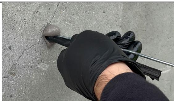
Inserire il connettore nel foro con l'uso del manico del secchiello raddrizzato.
