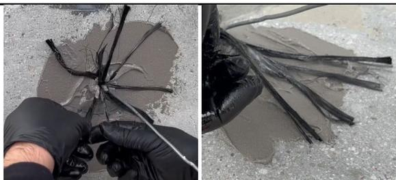
Posizionare i fasci di fibre sopra la resina per ottenere la forma richiesta. Impregnare le fibre con la resina (Sika Anchorfix®).
