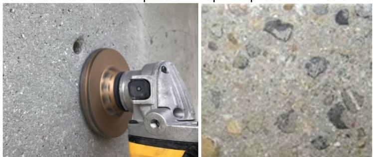
La resistenza del calcestruzzo del substrato deve essere verificata su tutti i progetti. Se il calcestruzzo deve essere riparato, occorre eseguire un ulteriore test dopo che la riparazione è stata completata e correttamente maturata.
