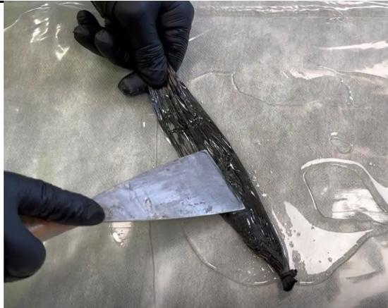
Impregnare il connettore con la resina (Sikadur®-300 o Sikadur®-52 Injection N) fino a completa saturazione. Mantenere un'estremità asciutta (circa 3 cm).
