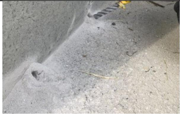
I bordi del foro devono essere arrotondati con un raggio di 20 mm, per evitare il tranciamento delle fibre del connettore in prossimità dello spigolo.
