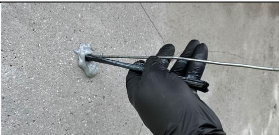
Inserire il connettore nel foro con l'uso del manico del secchiello raddrizzato.
