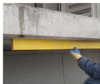
La superficie finale, correttamente preparata deve essere regolare, asciutta, priva di parti danneggiate o in distacco, priva di qualsiasi contaminante (polvere, particelle, lattime di cemento, olio, grasso, rivestimenti preesistenti, tracce di disarmante, cera, trattamenti superficiali eseguiti con impregnanti) che possa pregiudicare o diminuire l'efficacia dell'adesione del sistema di rinforzo strutturale al substrato.
