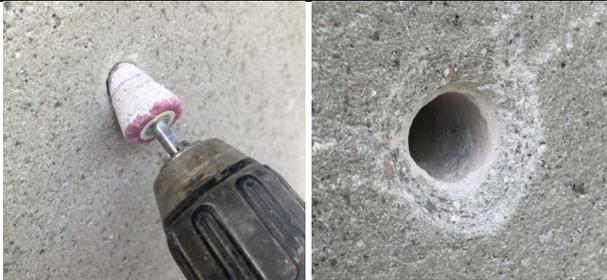
Il foro praticato deve essere accuratamente pulito in modo che sia privo di polvere e particelle sciolte. Pulire il foro con il compressore e la spazzola rotonda, alternando i due strumenti almeno tre volte.
