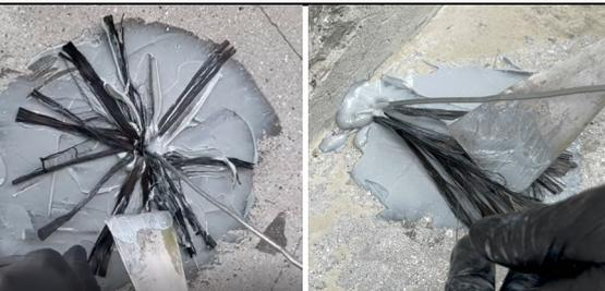
Posizionare i fasci di fibre sopra la resina per ottenere la forma richiesta. Impregnare le fibre con la resina
