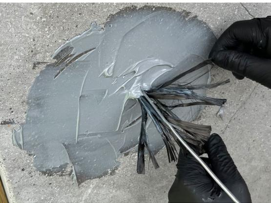
Aggiungere ulteriore resina Sikadur®-330 intorno al foro. Dividere le fibre asciutte del connettore in fasci e posizionarli sopra la resina. Impregnare le fibre con la resina.
