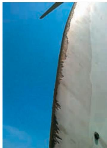
Riempimento e riparazione delle pale eoliche nelle zone erose perimetralmente
