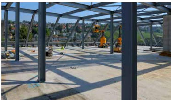
Il tetto è composto da una struttura in acciaio sopra alla soletta in calcestruzzo. È stato utilizzato SikaCor® PUR Neu in una tonalità di grigio RAL 7046 per una protezione a lunga durata e permanente dell'acciaio contro la corrosione.
