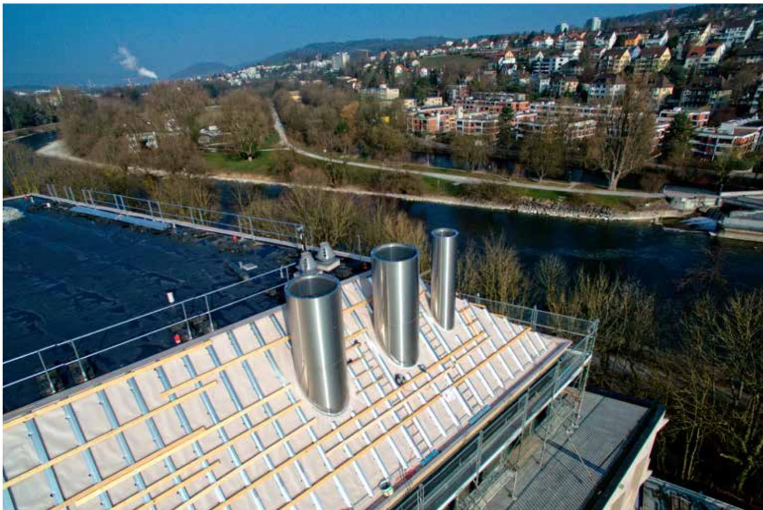
Questo tetto inclinato in metallo è stato impermeabilizzato con il sistema di guaine Sarnafil® TG 66-15 comprendente due strati di isolamento termico in lana minerale. Sopra al sistema di guaine si trovano dei tralicci su cui sono stati installati i pannelli solari.
