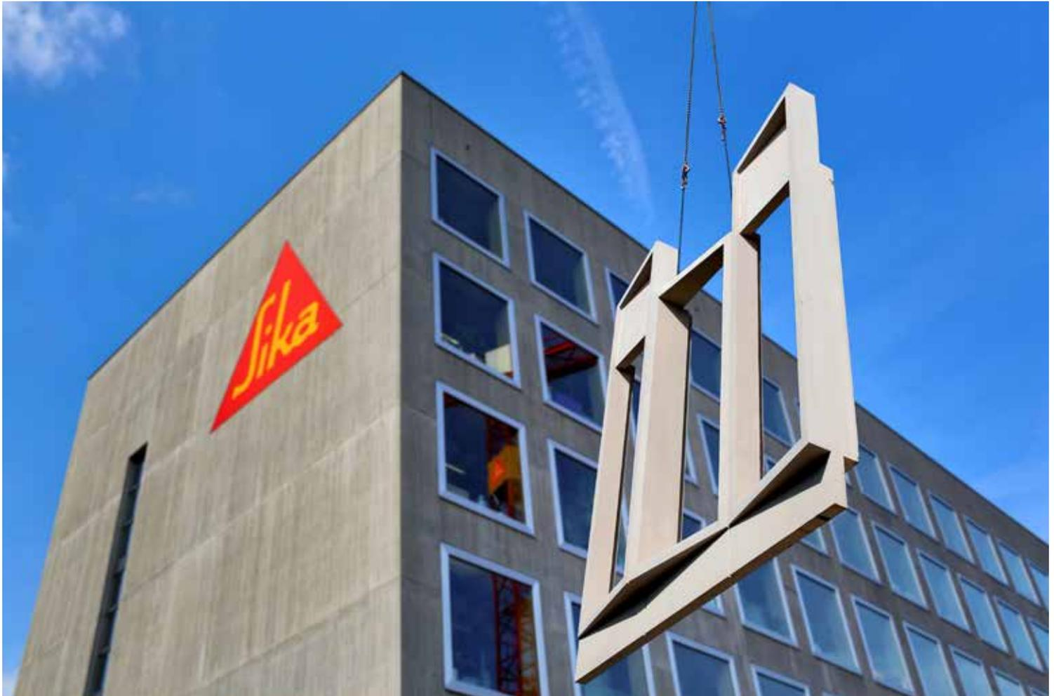
Prima di installare gli elementi prefabbricati della facciata, è stata rimossa l'impalcatura intorno all'edificio. Gli elementi sono stati poi sollevati con la gru dal team di sollevamento e messi in posizione sul telaio della facciata, uno alla volta e piano per piano.
