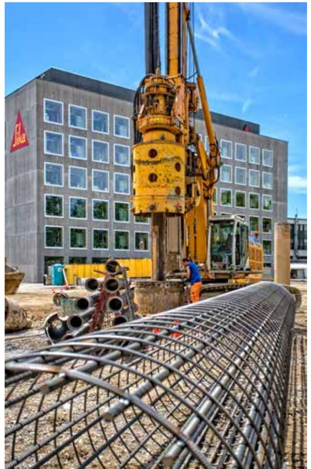
Date le condizioni del terreno ed il progetto dell'edificio, le fondazioni avevano bisogno di pali di vari tipi e dimensioni.
