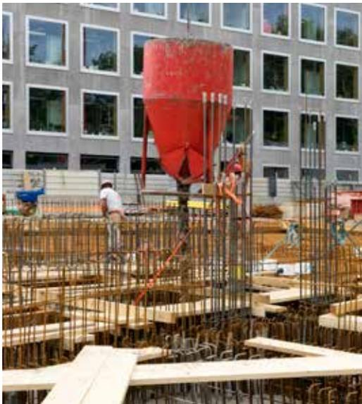
Per la soletta a piano terra e per le pareti principali era previsto un calcestruzzo impermeabile a ritiro ridotto. Questo risultato si poteva ottenere con un rapporto acqua/cemento ridotto e con l'utilizzo di Sika® Control-60.
