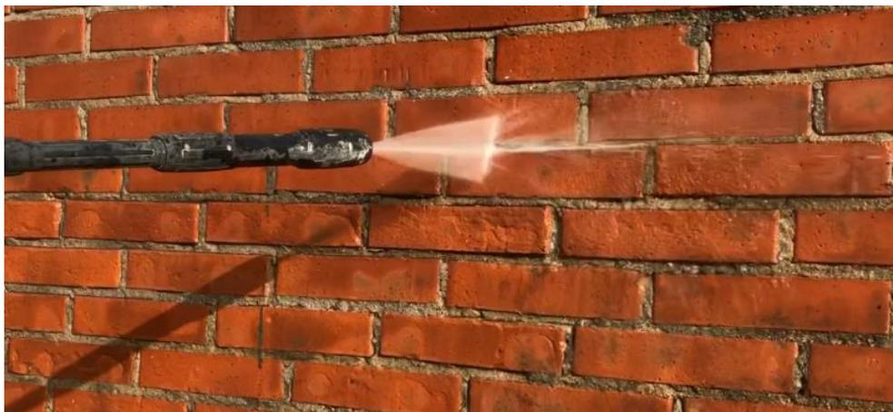
Si dovrà inoltre prestare particolare cura alle linee di fuga e ai giunti tra gli elementi che compongono la muratura, che dovranno essere scarnite in profondità e, se necessario, ristillate utilizzando la stessa malta Sika Mur®-200 M15, lasciandola indurire prima delle successive lavorazioni.
