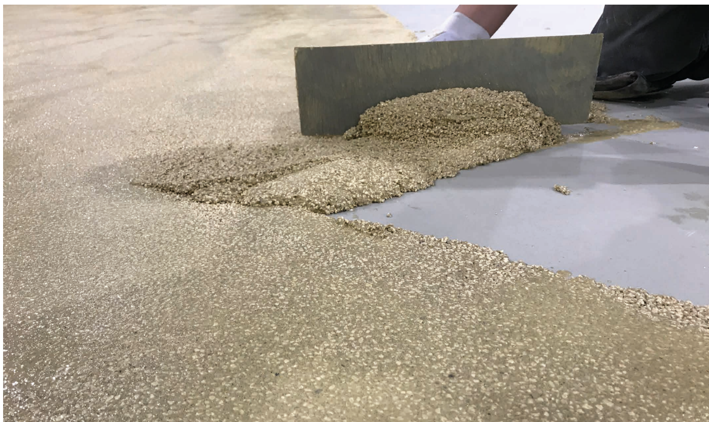
Sikafloor® PurCem® HM-20 HSR è un sistema applicabile a spatola con alta resistenza allo scivolamento. Può anche essere applicato con una "screed box".
