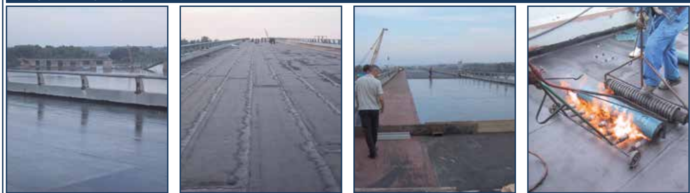
FASI DI IMPERMEABILIZZAZIONE CON PROTEADUO DEL PONTE DI BELGRADO
