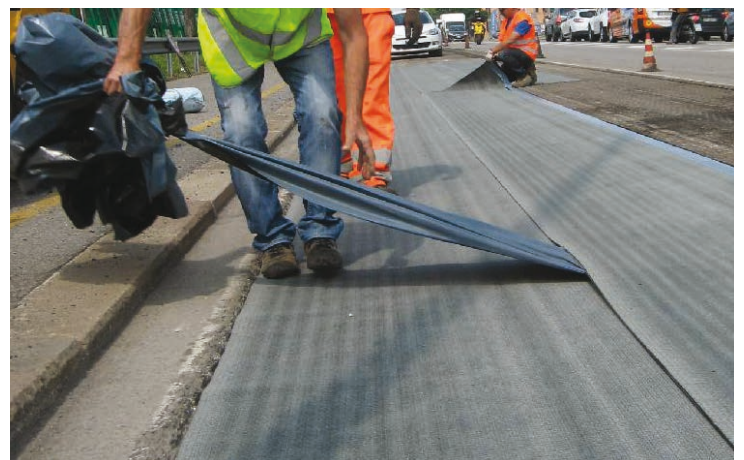
Asportazione del film siliconato che protegge la faccia inferiore del geocomposito
