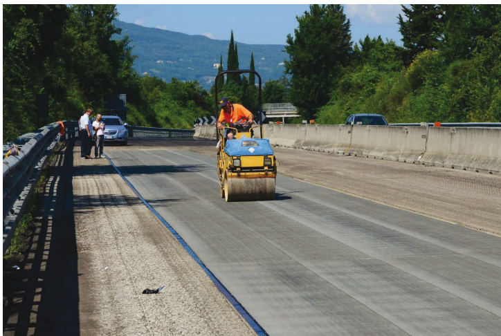
Rullatura dell'intera superficie
