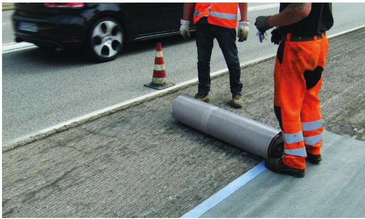
Applicazione a secco del geocomposito trascinando i fogli in maniera tale da stenderli allineati e senza pieghe
