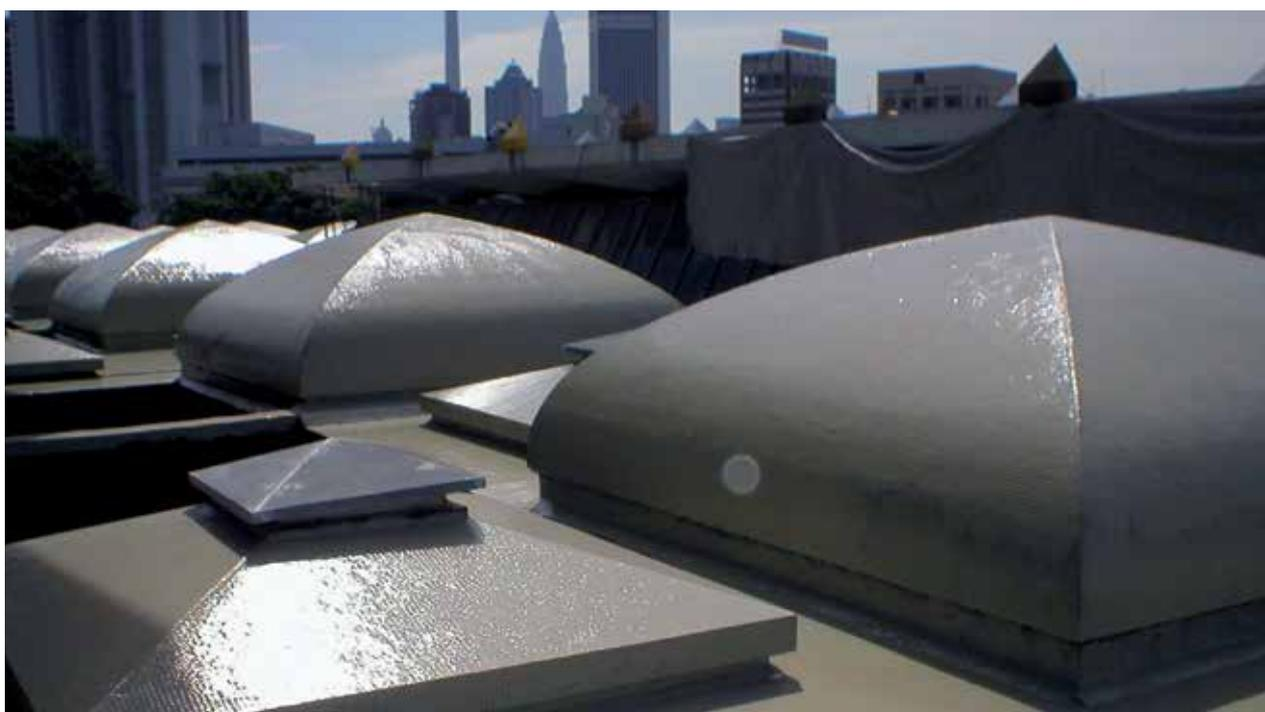
■ **Finitura poliuretana Sikalastic®-445 / 670 TC (monocomponente)/Sikalastic®-701 SF (bicomponente)** per conferire al sistema la cromia e l'estetica desiderata oltre che la resistenza ai raggi UV. Se scelte in determinate colorazioni, queste finiture contribuiscono all'aumento della emissività della copertura aumentando le prestazioni di impianti fotovoltaici installati in copertura.
