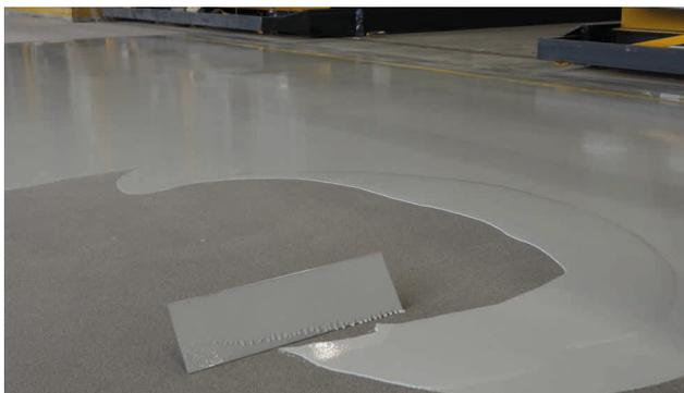
Con tali vantaggi, l'ovvio punto di forza unico è un sistema ultrarapido creato senza preparare il substrato attraverso la pallinatura. La combinazione di SikaScreed® HardTop, Sikafloor®-140 W Troweling Primer e Sikafloor®-151 / -161 in un arco di tempo di 48 ore forniscono più forza di adesione di un sistema tradizionale e senza avere un ulteriore passaggio di preparazione della malta appena installata prima della posa del rivestimento in resina.
