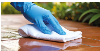
4. Rimozione del prodotto in eccesso
