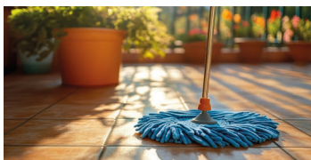
1. Pulizia del supporto
