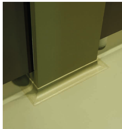
Connessione parete-pavimento realizzata con prodotti Sikafloor® e SikaGard® WallCoat.
