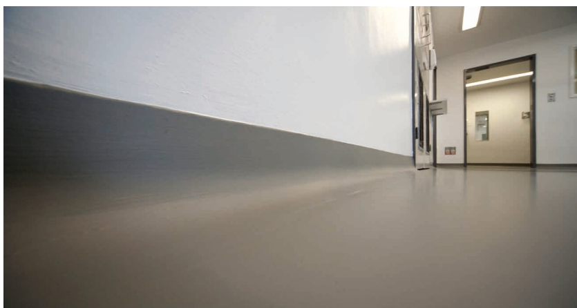
Connessione parete-pavimento realizzata con prodotti Sikafloor® e SikaGard® WallCoat.
