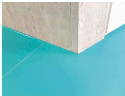
Soluzione di un giunti sigillato con Sikaflex® PRO-3.
