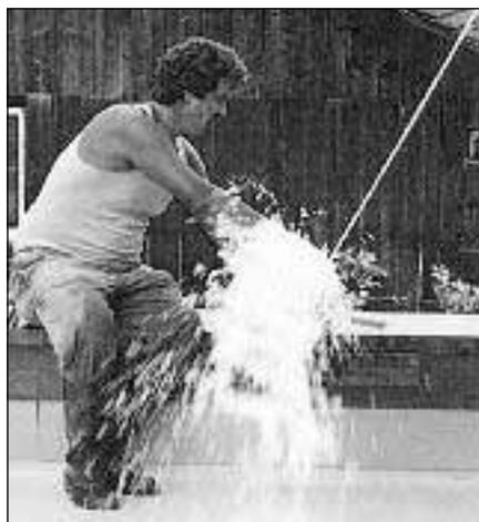
Riempimento con acqua della copertura per il controllo di tenuta.
