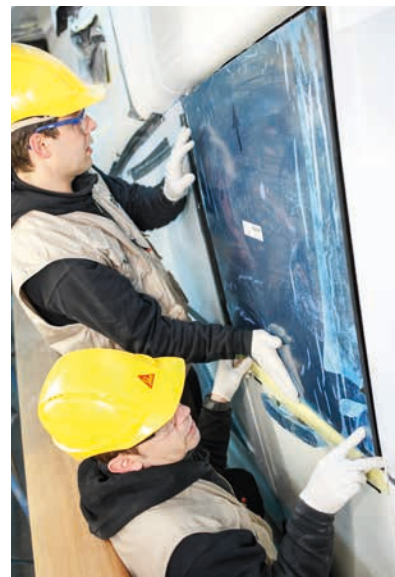
La finestra viene montata
