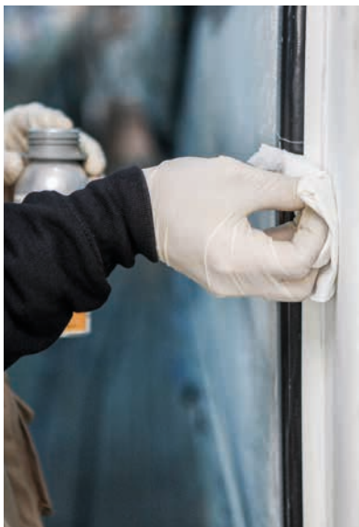
Pre-trattamento della zona dell'inchiostro ceramico con Sika® Aktivator-100
