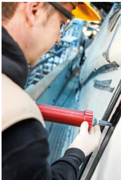
L'adesivo viene applicato al telaio della finestra
