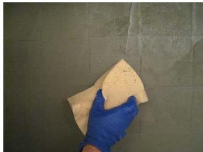
Dopo circa 4-6 ore a 20°C, sarà necessario carteggiare la superficie per eliminare tutte le imperfezioni in eccesso presenti sulla superficie. Il materiale deve essere completamente indurito senza pressare eccessivamente la superficie, senza danneggiare la carta abrasiva, ma con abbastanza pressione da ottenere una superficie liscia senza rilasciando eccessiva polvere.
