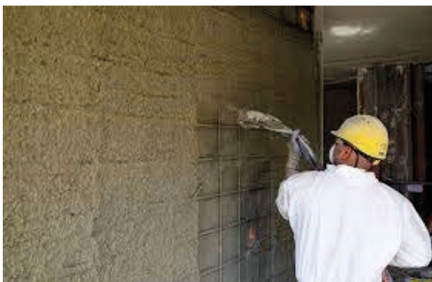
FIG. 7 - Applicazione della matrice inorganica SikaEmaco®
