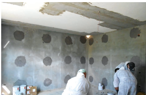
FIG. 10 - Applicazione di sistema FRCM con connettori
