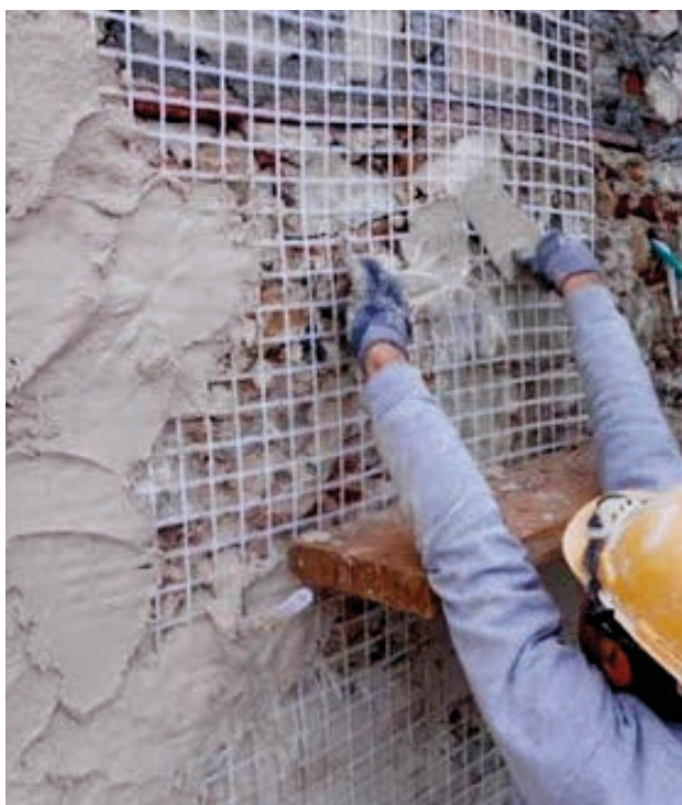
FIG. 4 - Messa in opera di sistemi FRCM
