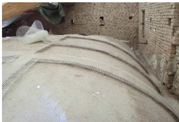
FIG. 13 - Rinforzo estradossale di volte, fasi di lavorazione
