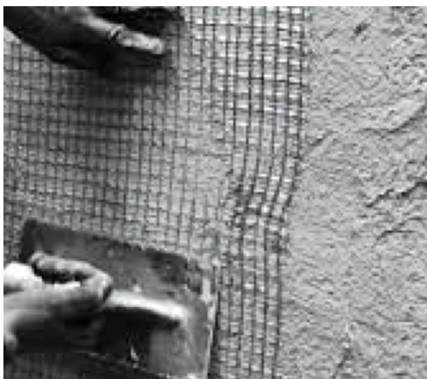
FIG. 17 - Posa FRCM su calcestruzzo
