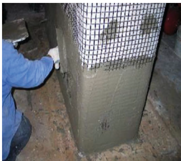
FIG. 11 - Confinamento di pilastro tramite FRM
