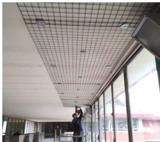
FIG. 18 - Posa in opera di Sika® Drain-100 NET
