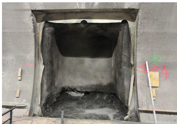
La nicchia scavata durante i lavori di manutenzione permette l'accessibilità al manto Sika in esercizio da 44 anni per i test di durata.
