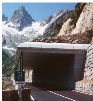
GALLERIE STRADALI PARAMASSI
