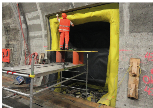
Impermeabilizzazione della nuova nicchia con il manto Sikaplan®, direttamente saldato al manto in PVC-p esistente.
