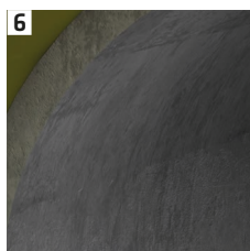
Rivestimento in calcestruzzo strutturale
