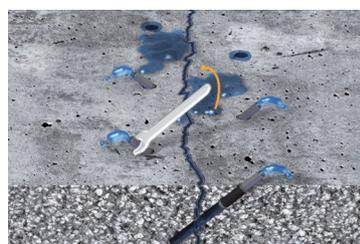
**2.** Inserire i packers meccanici. Serrare i packers meccanici in modo tale che possano resistere alla pressione massima di iniezione.
