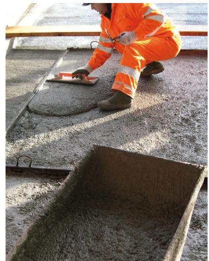
Applicazione di malta colabile ad espansione contrastata in aria, fibrorinforzata con fibre metalliche rigide SikaEmaco® S 444 FR, per il ripristino di giunti e di pavimentazioni soggette a carichi dinamici ed urti
