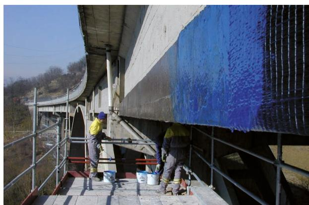
Esempi di applicazioni di materiali compositi FRP per il rinforzo delle strutture
