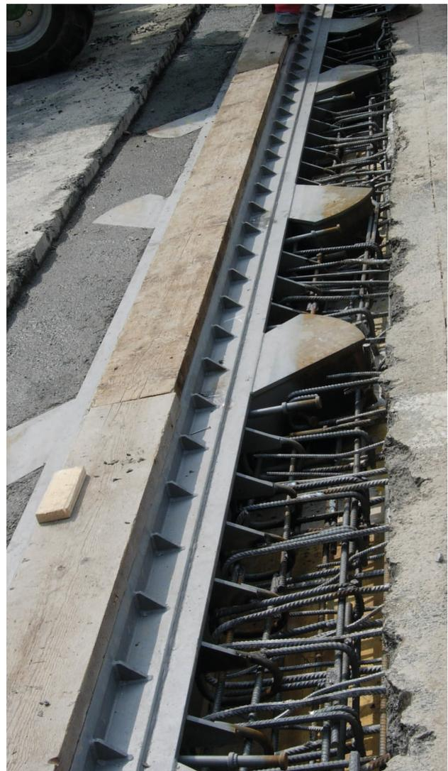
Preparazione per il colaggio di malta SikaEmaco® S 444 FR o SikaEmaco® T 1400 FR per il ripristino di giunto o di soletta soggetta ad alto traffico
