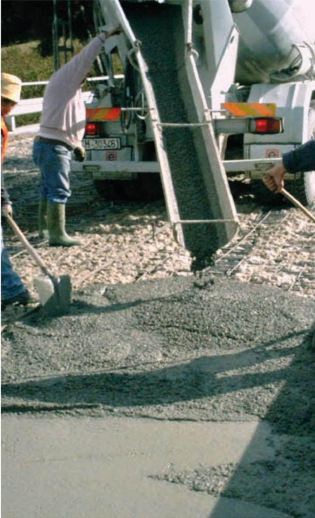
Pompaggio di betoncino colabile ad espansione contrastata in aria, fibrorinforzata con fibre inorganiche flessibili, SikaEmaco® S 485 FR, per il ripristino di una soletta su viadotto
