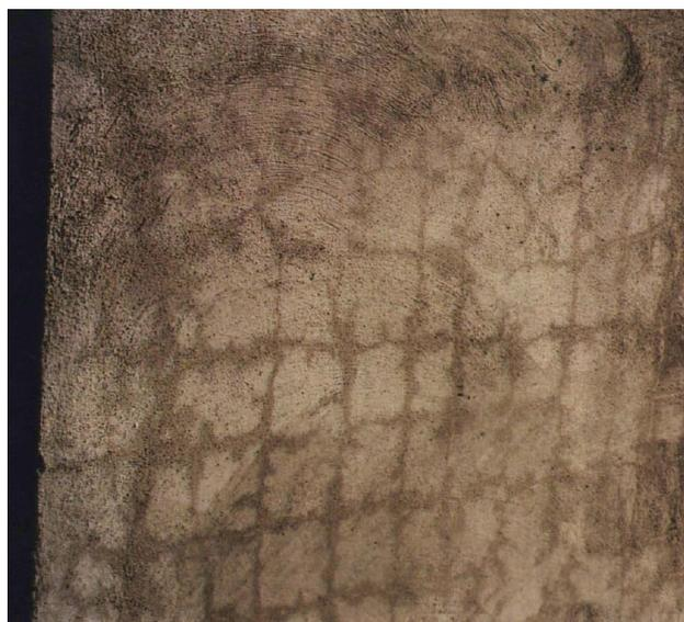
Esempio di ripristino di struttura in c.a. mal eseguito, a causa dell'errato posizionamento della rete elettrosaldata
