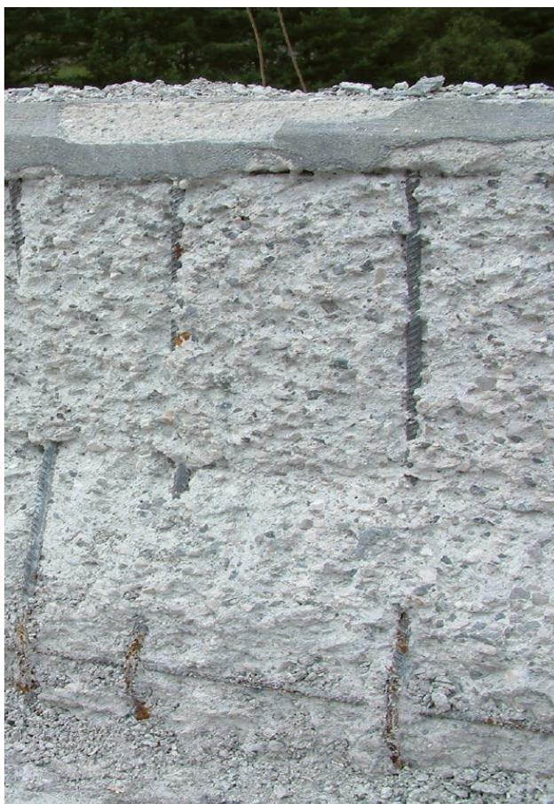
Esempio di degrado dovuto a cicli di gelo e disgelo
