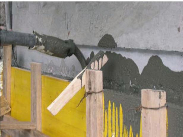
Colaggio mediante pompaggio entro cassero di malta SikaEmaco® S 465 MC
