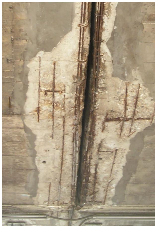
Esempio di degrado della soletta in presenza di carbonatazione del calcestruzzo ed al successivo processo di corrosione delle armature
