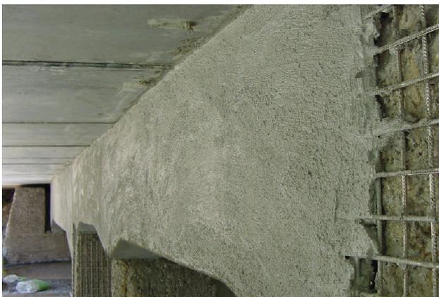
Applicazione di malta tixotropica ad espansione contrastata all'aria SikaEmaco® S 488 TIX in accoppiamento con rete elettrosaldata, per il ripristino di travature in cemento armato
