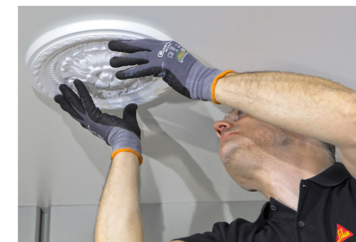
Lavori di decorazioni d'interni.
