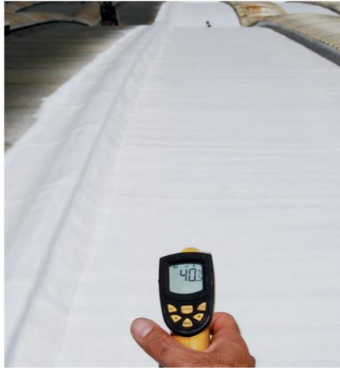
Temperatura del tetto dopo l'applicazione delle membrane liquide LAM
