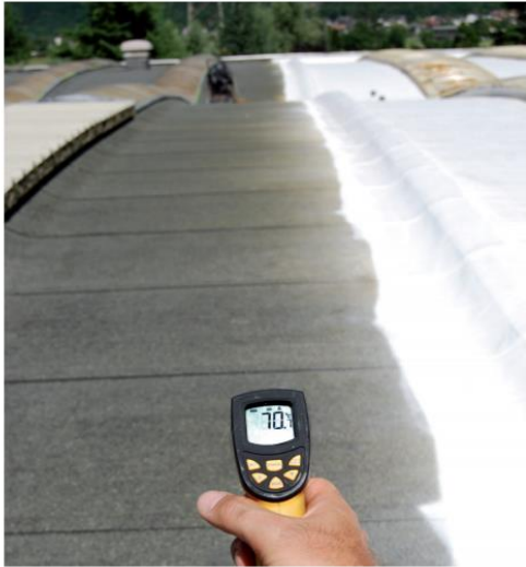
Temperatura del tetto prima dell'applicazione delle membrane liquide LAM
