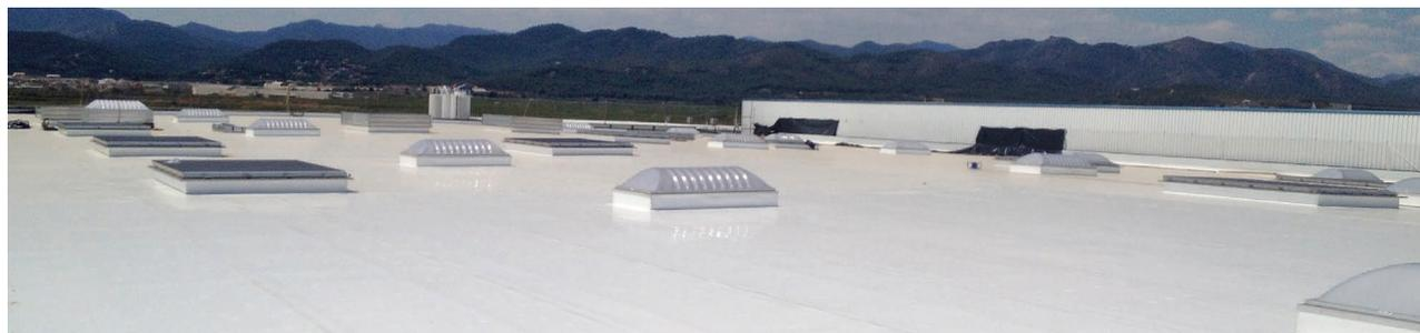
**Esempi di sistemi a fissaggio meccanico per nuove costruzioni o rifacimenti di tetti piani con supporto in lamiera grecata o calcestruzzo.**
