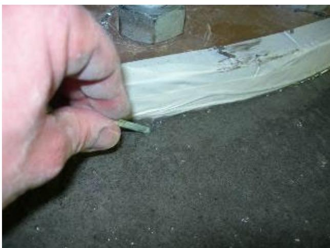
Controllare da ogni lato della piastra portante stuccata (con un grosso chiodo o un attrezzo simile) che il livello della malta sia pieno sotto la piastra e non solo sulla spalla prima di interrompere il flusso e la procedura di colatura.
