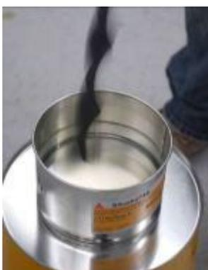
Miscela A + B con un mixer a basse velocità (300 - 400 rpm).
