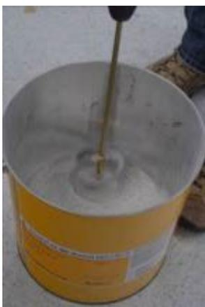
Mescolare approssimativamente per 5 minuti per ottenere una miscela omogenea in modo che il componente C sia accuratamente mescolato e amalgamato con la resina e l'indurente.
