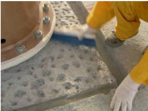
Rimozione della polvere e tutte le parti incoerenti di materiale dopo la sabbiatura o il getto d'acqua.
