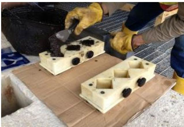
Per un controllo ottimale della qualità, colare alcuni campioni di prova con lo stesso materiale utilizzato per il lavoro di colatura.
