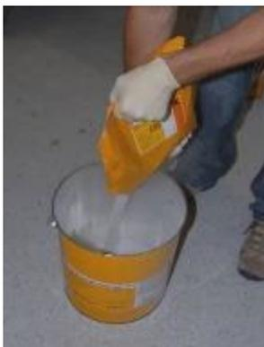
Aggiungere lentamente il contenuto del sacco del componente C (inglobare meno aria possibile durante la fase di aggiunta del componente C).
