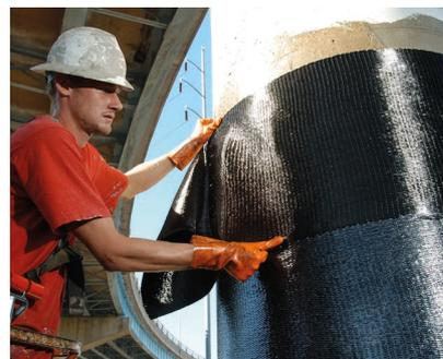
**I sistemi SikaWrap®** consentono di eseguire l'applicazione dei rinforzi FRP in tempi estremamente ridotti, grazie alle resine Sikadur®, che svolgono con un singolo prodotto la funzione di primer, livellante e impregnante
