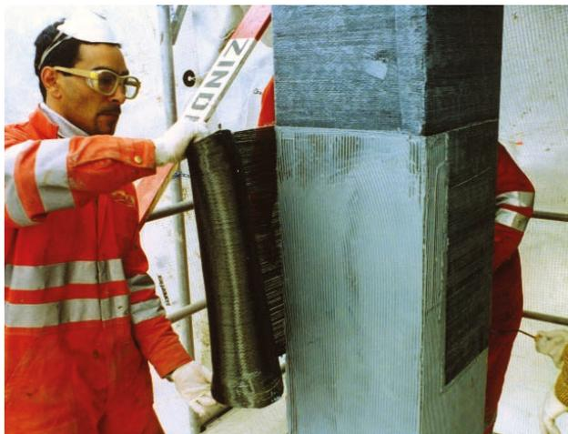
**Applicazione a umido:** per l'installazione di tessuti pre-impregnati oltre 450 g/m<sup>2</sup>
