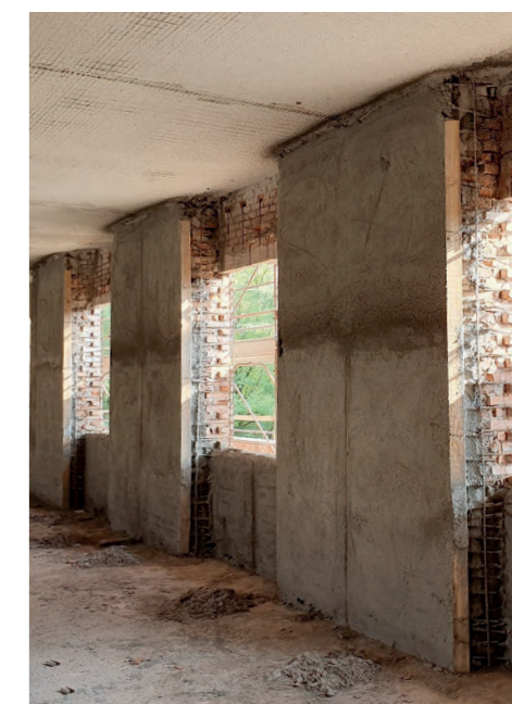
Realizzazione del betoncino strutturale con Sika MonoTop®-627 applicato a spruzzo in spessori di cm. 6 in un'unica passata
