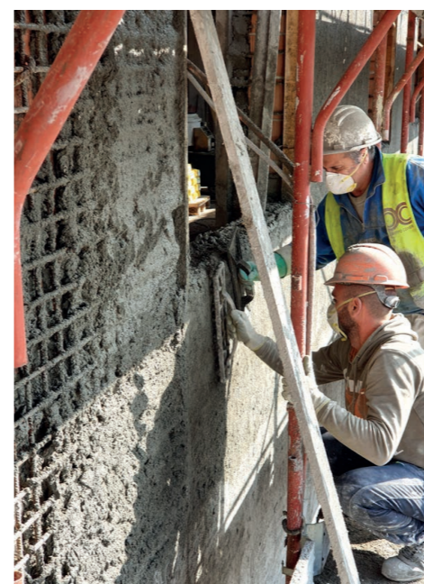
Appena il Sika MonoTop®-627 cominciava a rapprendersi si è proceduto alla lisciatura a fratazzo
