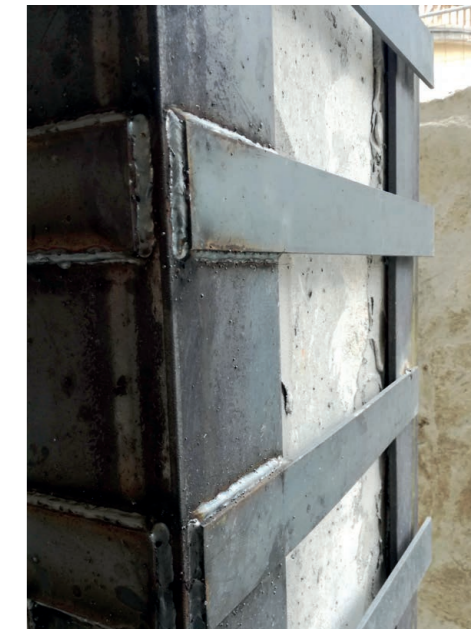
Incollaggio degli angolari in acciaio con la resina epossidica in stucco Sikadur®-31 CF
