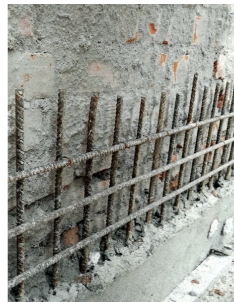
La nuova armatura del rinforzo di facciata è stata spinottata alla base nella fondazione
