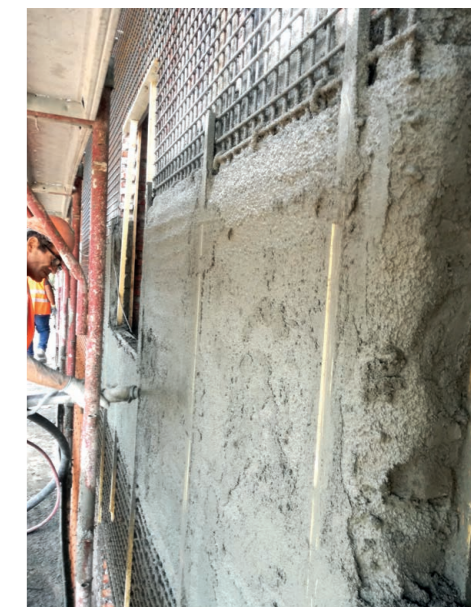
Realizzazione del betoncino strutturale con Sika MonoTop®-627 applicato a spruzzo in spessori di cm. 6 in un'unica passata
