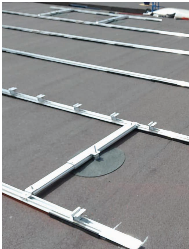
Installazione di ancoraggi SikaShield® Anchor e della struttura del sistema fotovoltaico.
