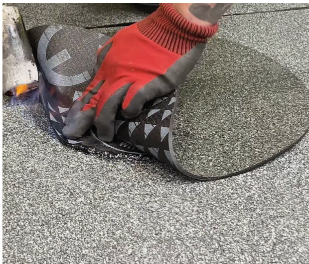
Applicazione a fiamma del primo foglio bituminoso liscio.
