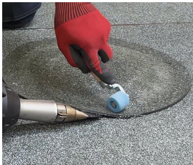
Applicazione ad aria calda del secondo foglio bituminoso ardesiato.
