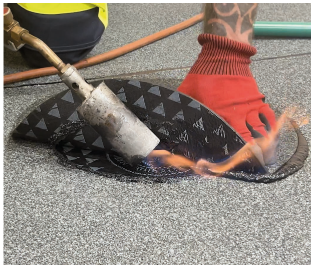
Applicazione a fiamma del secondo foglio bituminoso ardesiato.
