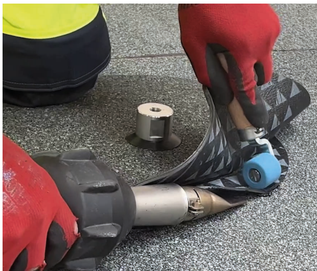
Applicazione ad aria calda del primo foglio bituminoso liscio.
