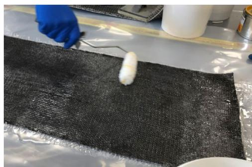
Rimuovere la resina in eccesso con l'ausilio di una spatola di gomma da stucco (vedere paragrafo 4.1). Il consumo di resina può facilmente essere determinato semplicemente per differenza di peso tra il tessuto secco ed il tessuto impregnato con il Sikadur®-300.
