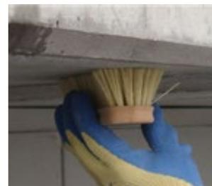
Gli angoli esterni e gli spigoli devono essere arrotondati, con un raggio minimo di 20 mm, o secondo le richieste del progetto. Questo può essere fatto mediante levigatura o mediante ricostruzione dell'intero spigolo con malte cementizie o epossidiche. Gli angoli interni devono essere arrotondati, mediante la realizzazione di sgusce, realizzate con malte cementizie o epossidiche.
