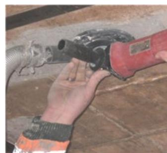
La preparazione meccanica ha lo scopo di rimuovere lattime di cemento, eventuali tracce di disarmanti, oli, grassi e ogni parte friabile in distacco e di ottenere una superficie regolare e con tessitura aperta. Ogni difetto superficiale come ad esempio nidi di ghiaia, vuoti o soffiature devono essere ben visibili.
