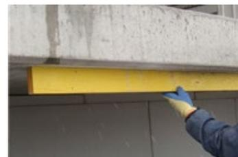
La superficie finale, correttamente preparata deve essere regolare, asciutta, priva di parti danneggiate o in distacco, priva di qualsiasi contaminante (polvere, particelle, lattime di cemento, olio, grasso, rivestimenti preesistenti, tracce di disarmante, cera, trattamenti superficiali eseguiti con impregnanti) che possa pregiudicare o diminuire l'efficacia dell'adesione del sistema di rinforzo strutturale al substrato.
