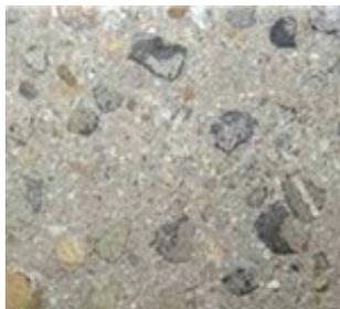
Tutte le superfici precedentemente preparate devono essere spazzolate, soffiate con aria compressa e poi pulite con aspirapolvere, al fine di ottenere una superficie senza tracce di polvere. Nessuna parte in distacco deve essere lasciata sulla superficie. La foto a sinistra mostra una superficie di calcestruzzo sufficientemente levigata con l'inerte a vista e una texture aperta.
