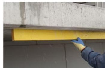
Il livellamento o levigatura o pulizia della superficie di calcestruzzo dovrebbe essere eseguito poco prima dell'installazione del sistema di rinforzo, altrimenti potrebbe accadere che la superficie si sporchi o si contamini ancora. In questo caso è necessario procedere ad una nuova fase di pulizia, per evitare di avere ripercussioni negative sulle prestazioni di adesione del sistema di rinforzo al substrato.
