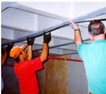
Pulire le lamine con un panno pulito, imbevuto di Sika Colma® Cleaner (o un altro pulitore a base di isopropanolo), al fine di rimuovere qualunque residuo di polvere o grasso. Prima di applicare l'adesivo epossidico, assicurarsi che il solvente sia totalmente evaporato e la superficie della lamina sia completamente pulita e asciutta.
