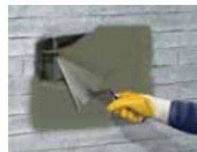
La scelta del materiale idoneo da utilizzarsi prima dell'applicazione dei sistemi di rinforzo dipende dalle tempistiche a disposizione per l'esecuzione del cantiere. L'utilizzo di malte epossidiche consente l'applicazione dei rinforzi in pochissimi giorni. L'utilizzo di malte cementizie richiede attese molto più lunghe.
