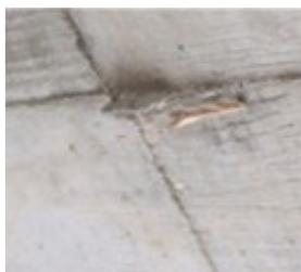
Prima di iniziare con la preparazione ed il livellamento del substrato per l'applicazione del sistema Sika® CarboDur®, si deve eseguire un'accurata verifica dello stesso per la rimozione di tutte le parti ammalorate ed in fase di distacco (calcestruzzo degradato, zone di incipiente corrosione, pezzi di cassetta rimasti attaccati al cls e altro).
