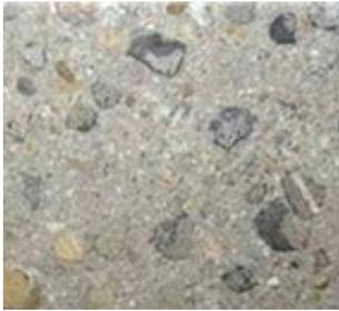
Al termine della fase di levigatura/regolarizzazione e poco prima dell'installazione delle lamine pultruse, la superficie finale, deve essere spazzolata per rimuovere ogni parte incoerente e aspirata per eliminare ogni traccia di polvere. La foto a sinistra mostra una superficie di calcestruzzo sufficientemente levigata con l'inerte a vista e una texture aperta.
