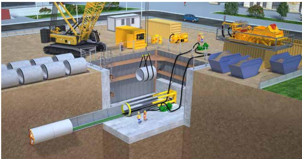
Il Microtunneling è un'alternativa rapida ai sistemi di installazione di tubature convenzionali. Si tratta di un metodo completamente automatizzato per l'installazione di tubature, che permette di non scavare i volumi di terra fino alla superficie. Le micro TBM sono generalmente utilizzate per lo scavo di molte delle principali tubature di pubblica utilità, come acqua dolce, acque reflue, petrolio, gas, comunicazioni ed elettricità.
