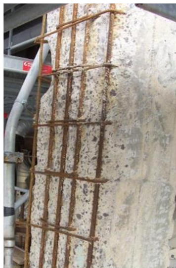
Rimozione parti in distacco
