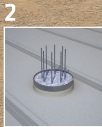
2 Soluzioni di dettaglio SikaProof®, chiusura teste di pali
