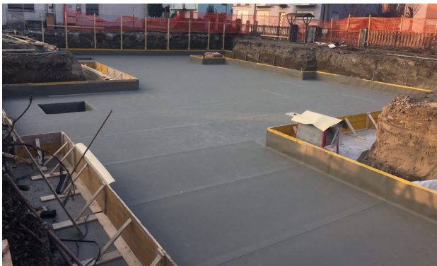
Applicazione tipica di SikaProof® A+ sul magro di fondazione
