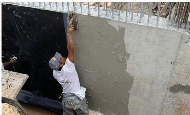
Applicazione adesivo cementizio SikaShield® W-1 posato direttamente su supporto umido.
