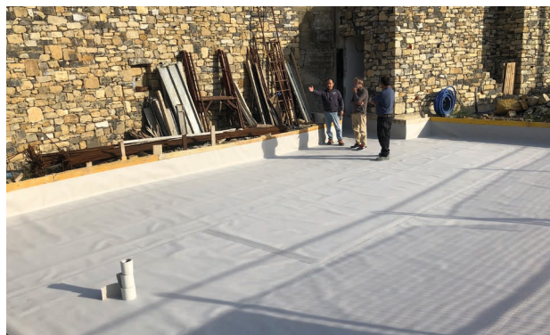
Scavo a cielo aperto con SikaProof®-808 e nastro SikaProof® Tape-120.
