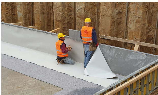
Applicazione tipica di SikaProof®-808 sul magro di fondazione e risvolti verticali.
