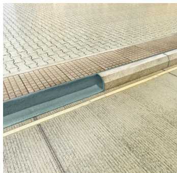
Incollaggio di pietra e calcestruzzo.
