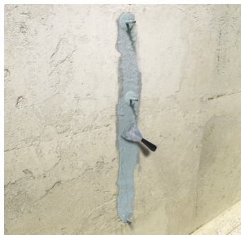
Stuccatura delle fessure.
