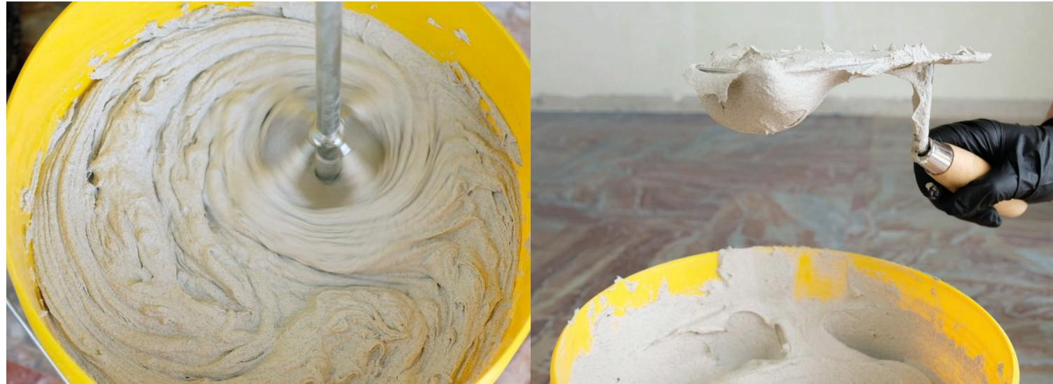
**MISCELAZIONE:** Versare l'acqua nel dosaggio prescritto in scheda tecnica e miscelare ad una velocità lenta e costante di 500 giri/min.
