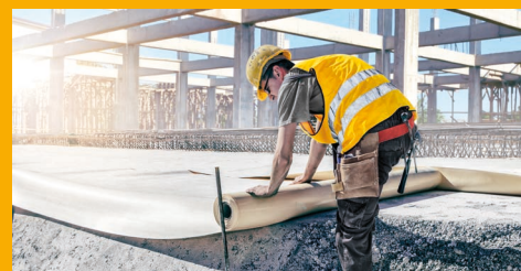
IMPERMEABILIZZAZIONE DI EDIFICI
