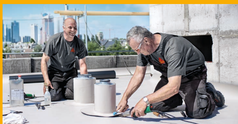
IMPERMEABILIZZAZIONE DI TETTI PIANI
