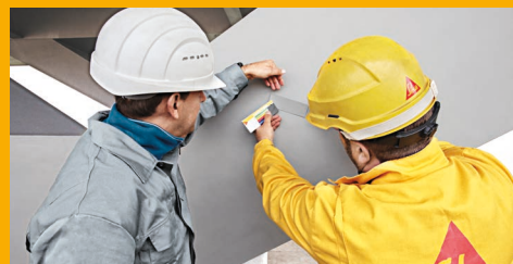
ASSISTENZA E CONSULENZA IN CANTIERE
