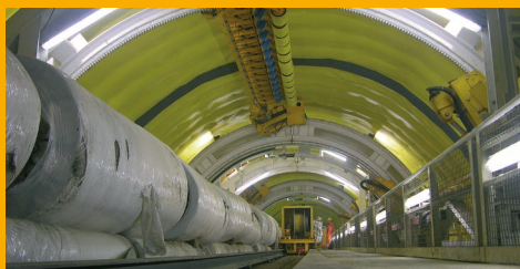
COSTRUZIONE DI GALLERIE
