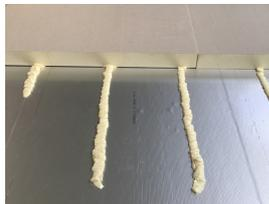
7. Applicare un'adeguata quantità di Sika® RoofBond in base ai requisiti della zona di carico del vento della copertura.
