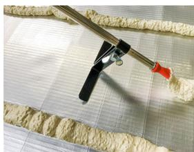
6. Applicare Sika® RoofBond direttamente sulla superficie, quindi premere rapidamente il pannello isolante sul tetto piano con una leggera pressione e regolare. Utilizzare l'apposito distanziatore per garantire la corretta distanza tra beccuccio e substrato.
