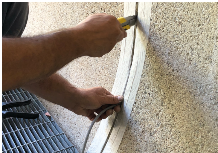
APPLICAZIONE DEI SOTTOGIUNTI Ethafoam
