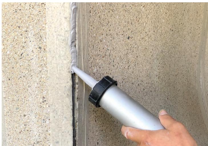
SIGILLATURA CON SikaHyflex®-250 Facade
