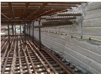
I sistemi di tubi a iniezione SikaFuko® vengono installati prima della cementazione e sono pronti dopo l'indurimento del calcestruzzo. In caso di eventuali perdite, il sistema consente l'accesso diretto e veloce alla maggior parte delle aree della struttura in calcestruzzo impermeabile.
