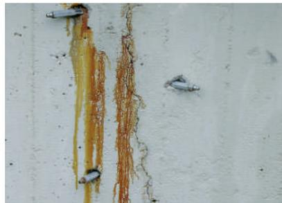
L'iniezione può essere utilizzata non solo per sigillare una struttura in calcestruzzo ma anche per migliorarne o ripristinare l'integrità strutturale. Le crepe nelle aree non omogenee possono essere incollate, riempite e sigillate con un materiale rigido.
