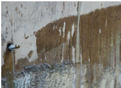
Dopo che il materiale è stato usato per fermare l'ingresso di acqua, la perdita deve essere re-iniettata per sigillare la struttura in modo duraturo. Per le zone umide senza ingresso di acqua pesante, il materiale flessibile può essere iniettato direttamente nella zona della crepa o del giunto.
