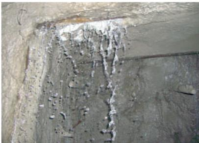
Crepe e giunti danneggiati possono causare l'ingresso di acqua diretta e pesante. Questo ingresso d'acqua deve essere immediatamente interrotto con un materiale a reazione rapida ed espansiva prima di procedere con la riparazione finale.
