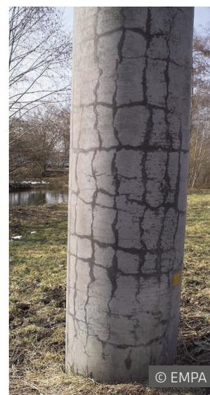
L'aspetto del danno dell'ASR può essere constatato molto bene nell'essiccazione della superficie del calcestruzzo di questo pilone di un ponte. I danni possono comparire dopo anni o solo dopo decenni.
