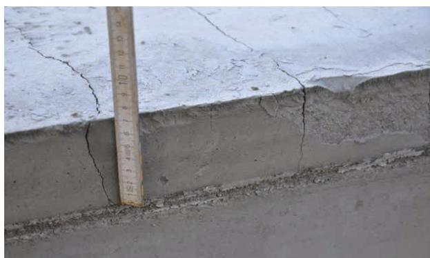
Crepe dovute a ritiro plastico in una pavimentazione di calcestruzzo causate da un'insufficiente protezione superficiale prima che avvenisse una asciugatura prematura.
