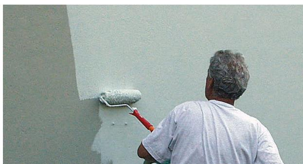
Rivestimenti protettivi a base di resine epossidiche vengono applicati su tutta la superficie dopo la riprofilatura della superficie del calcestruzzo con malta di riparazione resistente ai solfati arricchita con materiale sintetico.
