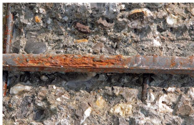
Danni alla struttura in calcestruzzo dovuti a una copertura di calcestruzzo insufficiente e alla bassa qualità del calcestruzzo
