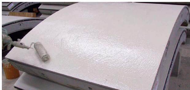
Immediatamente dopo l'indurimento in un canale a vapore, la superficie di calcestruzzo dei tratti di rivestimento del tunnel è rivestita con emulsione epossidica a base di acqua che viene assorbita anche nei pori più piccoli, generando così un rivestimento protettivo e sigillato.
