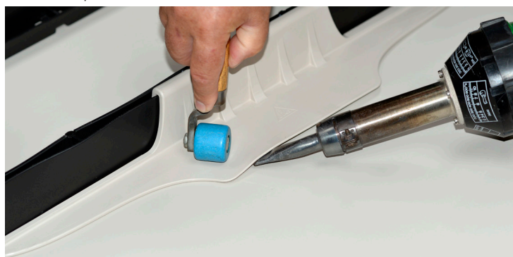
Saldatura per termofusione ad aria calda dei Sika® SolarClick
