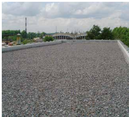
Coperture zavorrate ghiaia
