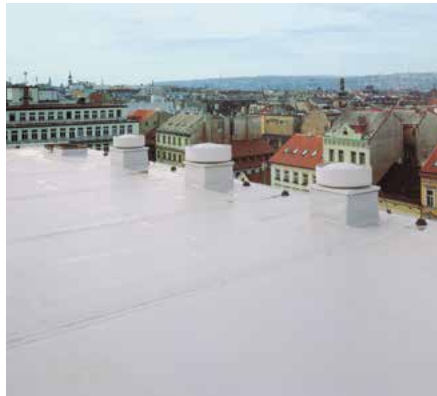
Coperture a vista
