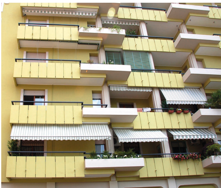
Protezione della struttura con verniciatura elastica protettiva Sikagard® -680 S Betoncolor
