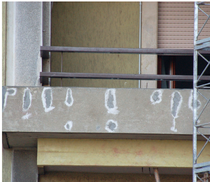
Riparazione localizzata con SikaMonoTop® -441 Unika
