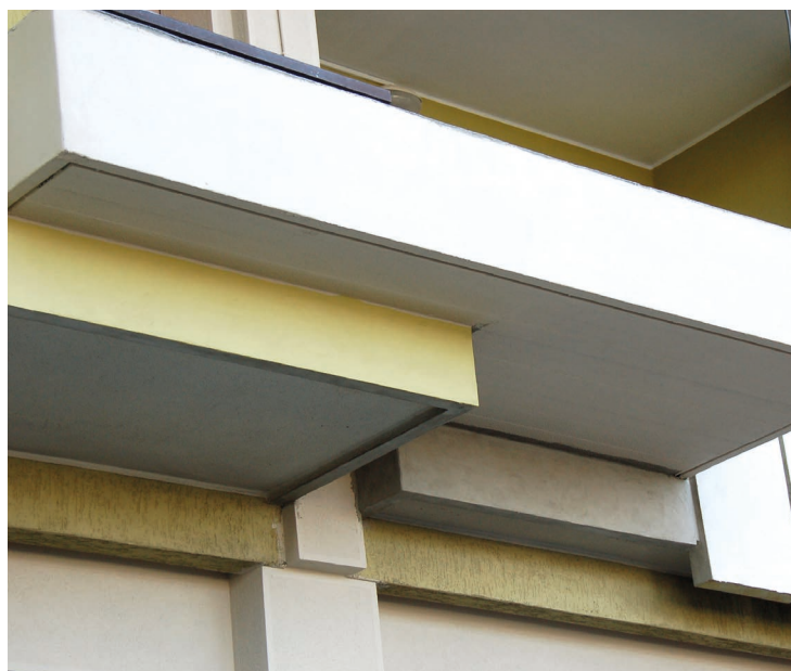
Verniciatura protettiva della facciate con pittura acrilica Sikamur® -Color S
