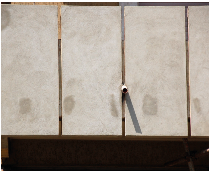
Riparazione localizzata con SikaMonoTop® -441 Unika
