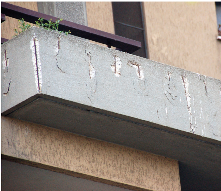
Preparazione e passivazione delle armature scoperte
