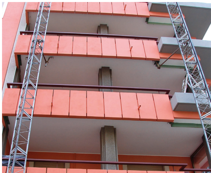
Protezione della struttura con verniciatura elastica protettiva Sikagard® -680 S Betoncolor
