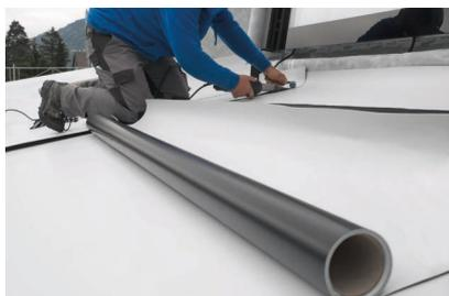
Altamente flessibile come l'EPDM, anche a basse temperature, per permettere una più rapida stesura dei manti in cantiere.
