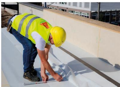
2. Contrassegnare la posizione dello spigolo superiore del parapetto
