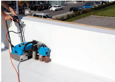
5. Saldatura ad aria calda della cimosa al piede
