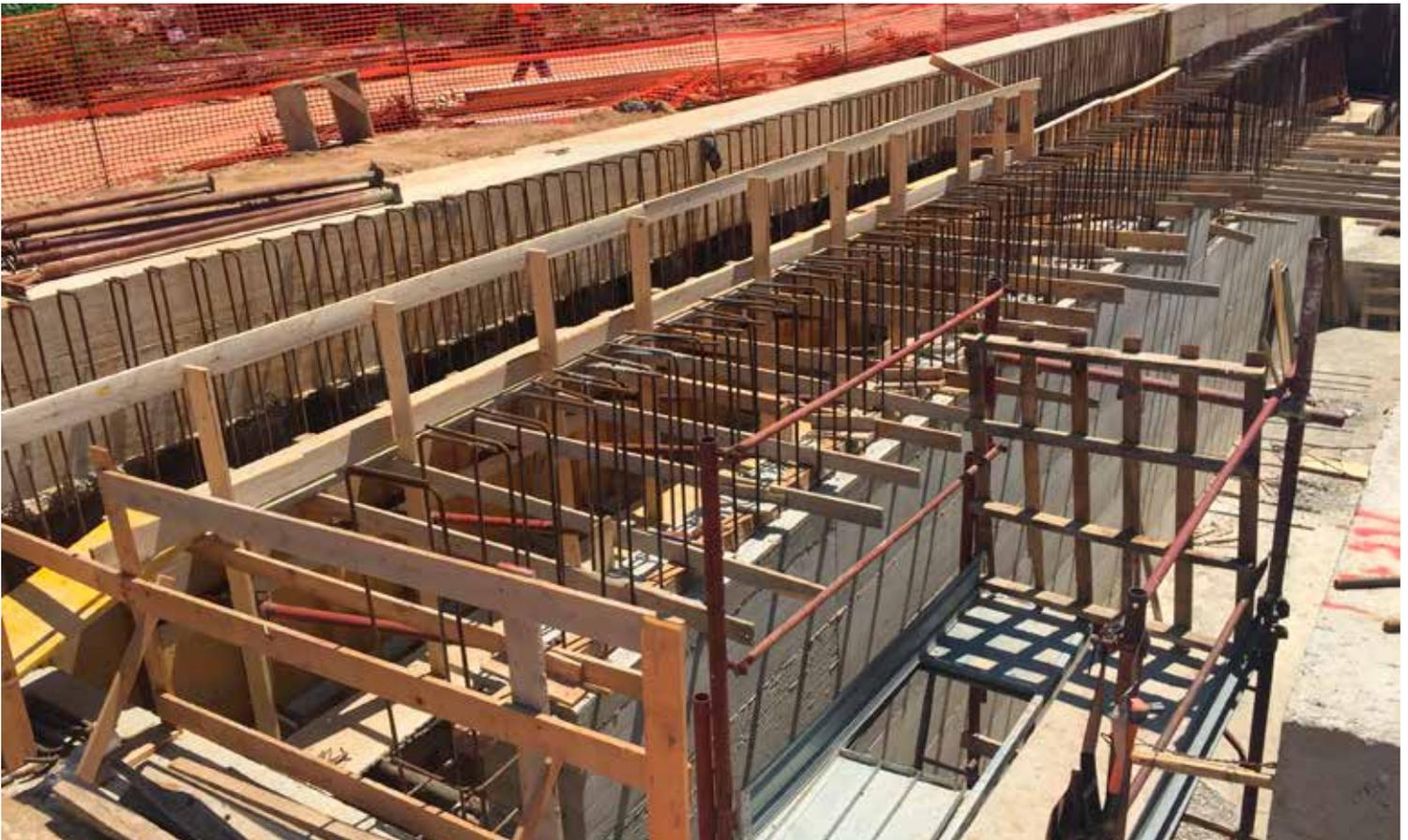
Durante la fase di scasso sono state ripristinate alcune parti ammalorate con l'utilizzo di **SikaRep®**. Per lavorazioni di inghisaggio delle armature, in alcune zone della stazione è stato utilizzato l'ancorante chimico **Sika AnchorFix®-3+**.
