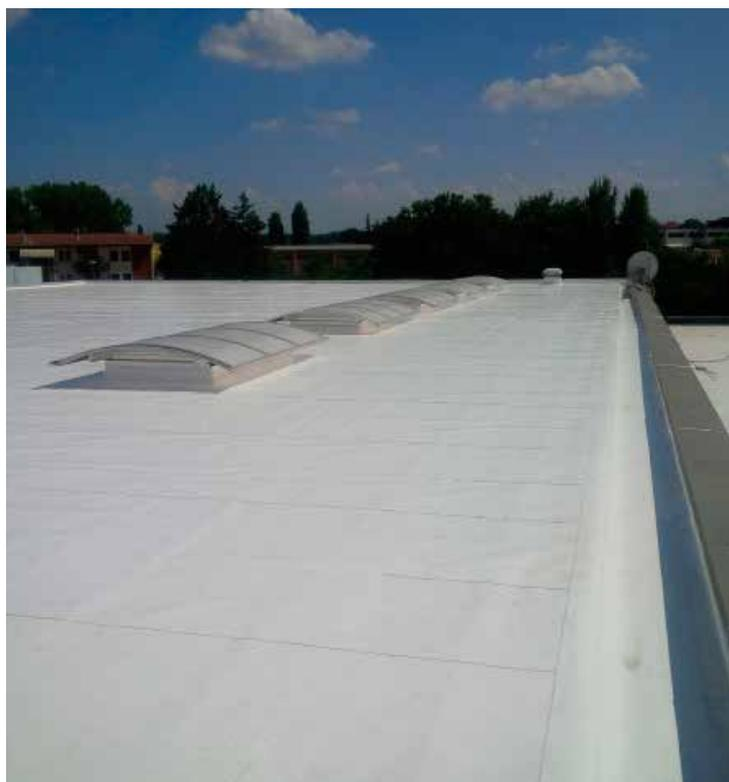
di ottenere giunzioni di elevata qualità, ad assoluta tenuta idraulica; l'assenza di opere di manutenzione necessarie, assicura l'economicità della soluzione tecnica **Sarnafil®** nel tempo.
